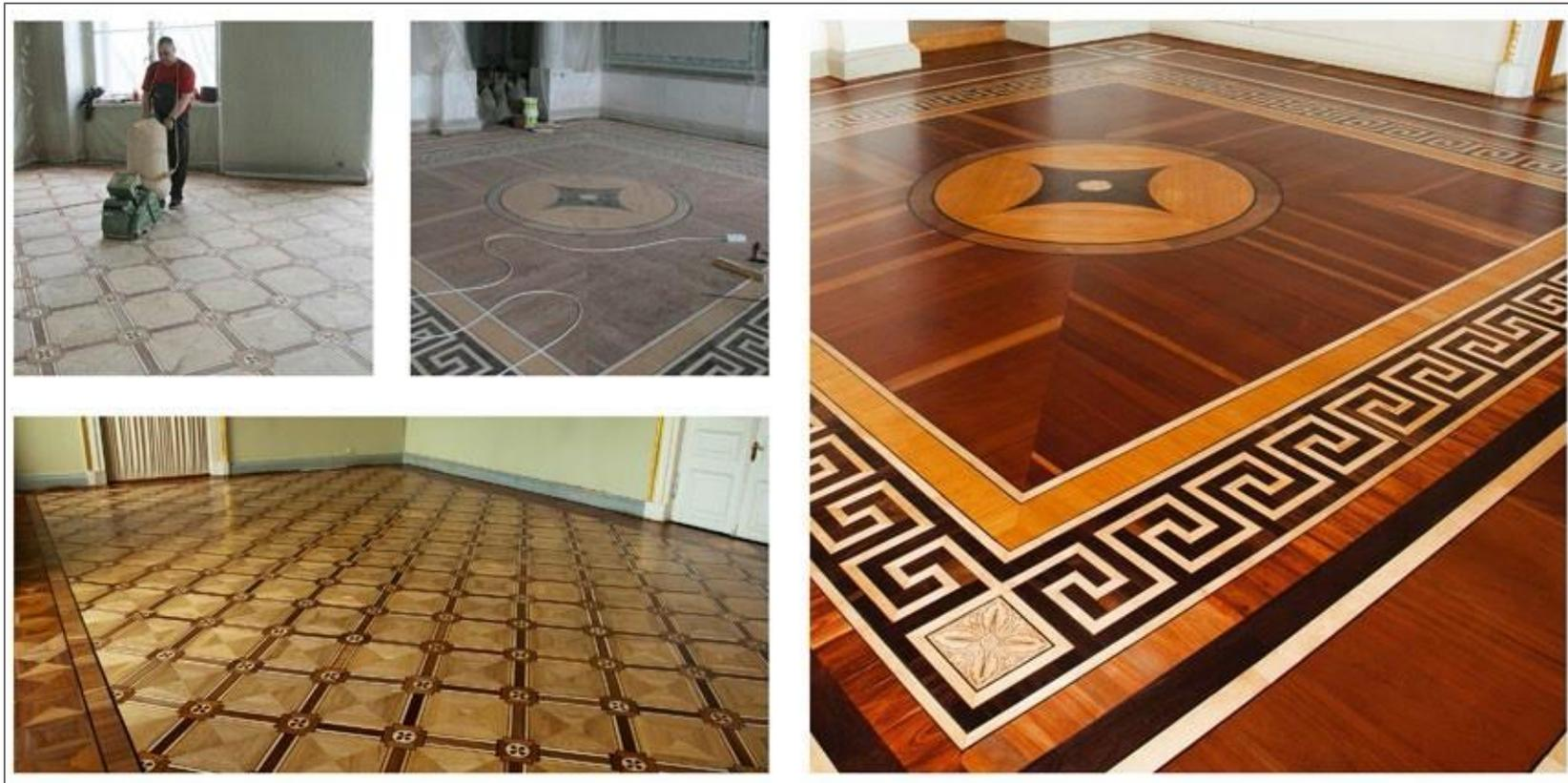
公司成功修复了具有160年历史的镶木地板（512平方米）。对镶木地板的评估显示由于大量的脚踏和缺乏亮漆保护，镶木地板的外观和功能几乎完全被破坏。专业人员采用部分替换的方式加强了地板龙骨，安装了更多支撑。70%镶木地板需要完全更换。根据专家证据和档案精心挑选了木材品种。
