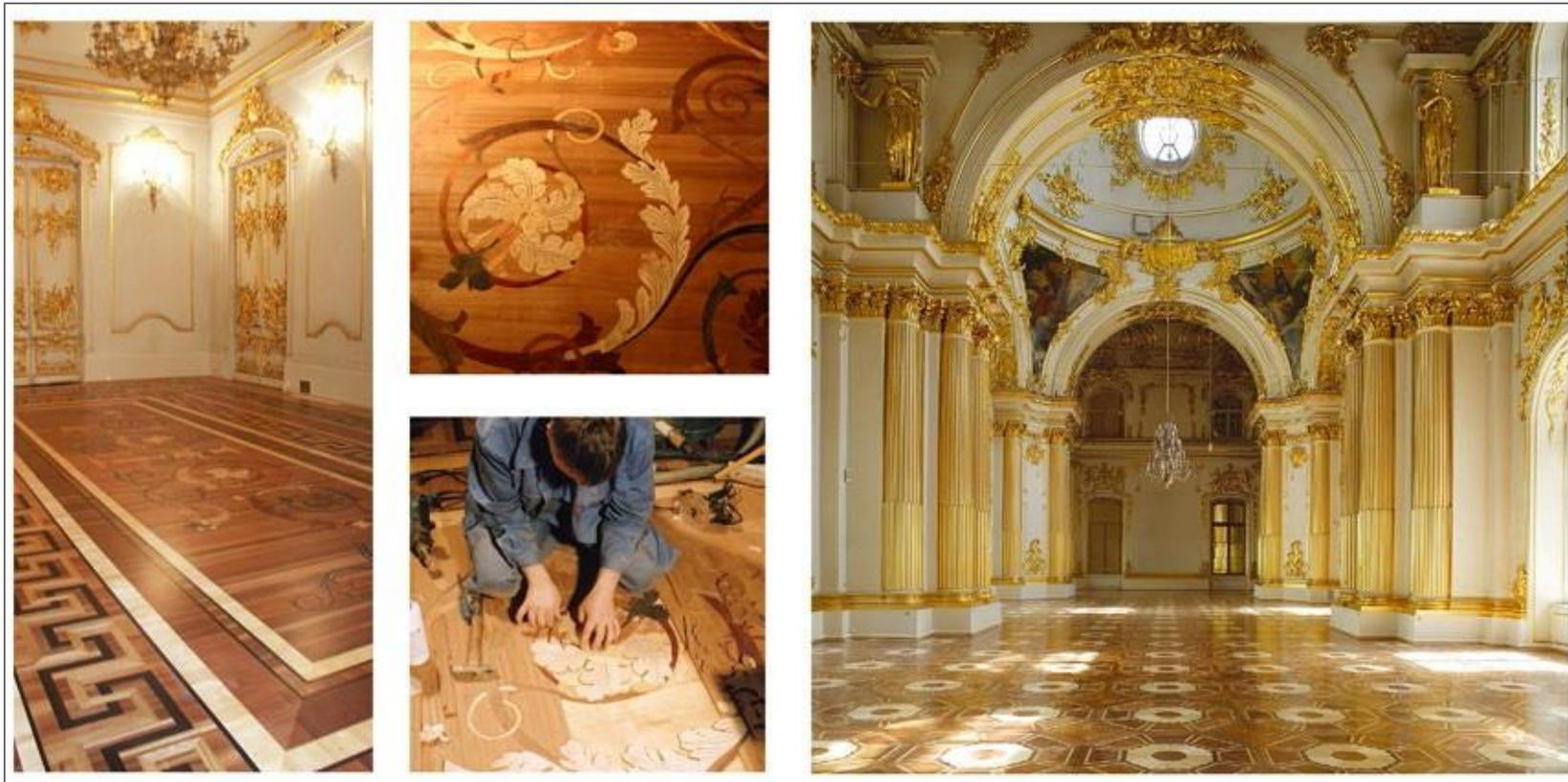
冬宫博物馆著名的拼花镶木地板出自20世纪杰出建筑师之手。这些地板已明显超龄。“冬宫地板”项目于2000年启动。此项目修复了博物馆的地板。超过35%地板（即曲线部分）已缺失。在镶木地板修复期间，专业人员利用了博物馆地窖保存的旧木板（各种珍贵木材品种的板材）。大教堂前厅使用了14种木材。在修复期间，古老的雕刻得以修复。大教堂的修复工作持续了4个月（450平方米）。前厅内的镶木地板是博物馆内最古老的地板之一。在修复前，其厚度仅为2-3毫米，部分地板已缺失（后来在这些部位插入其他木材品种），基材已严重受损。
